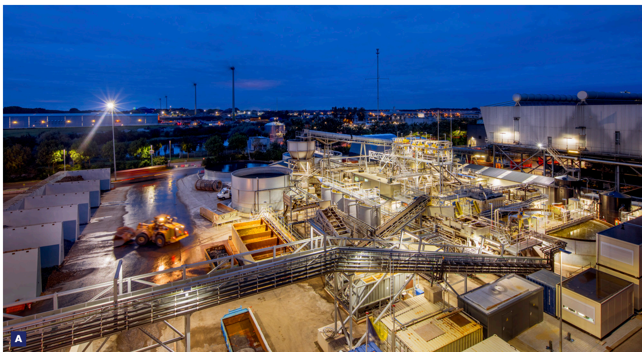
A Bodemasreinigingsinstallatie in Alkmaar
